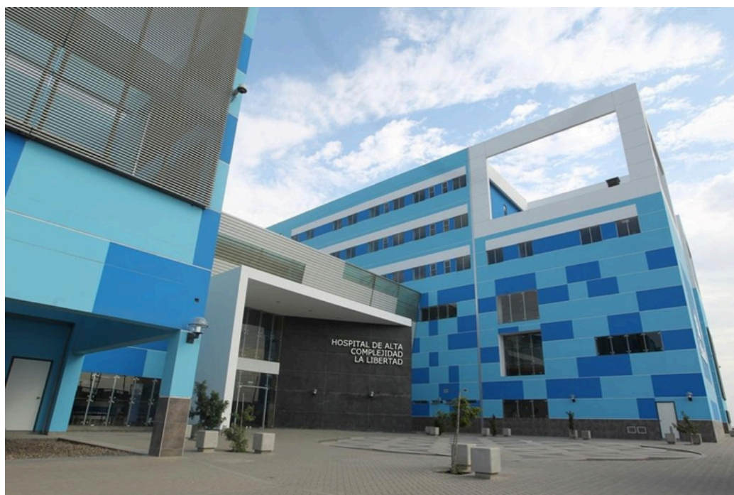
Foto N°2. Frontis del Hospital de Alta Complejidad
